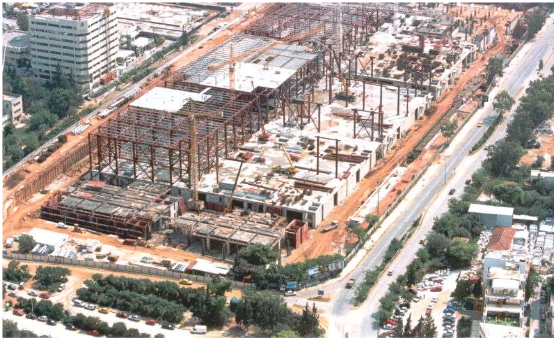
Ολυμπιακό Κέντρο Ραδιοτηλεόρασης: Φάση ολοκλήρωσης κατασκευών σκυροδέματος και αρχικό στάδιο συναρμολόγησης μεταλλικής κατασκευής
